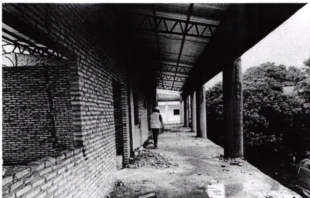
Vista de estructura expuesta de techo en circulación 2do Piso
