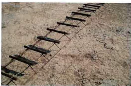
Colocación con Canastos
