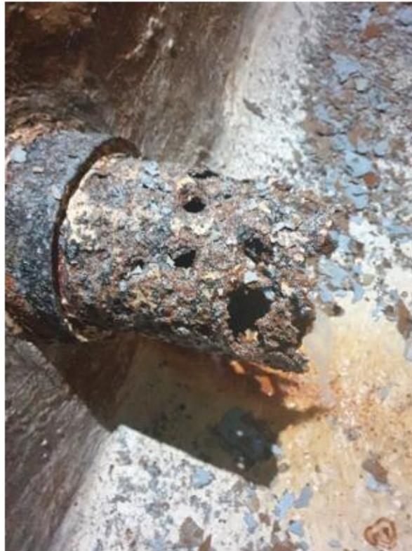
Figura 17 - Salida de agua – Tanque Inferior
