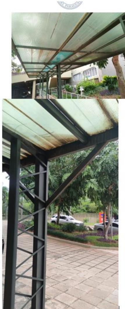
Figura 41 - Estructura metálica y techo de policarbonato, sector rampa a entrada BCP
