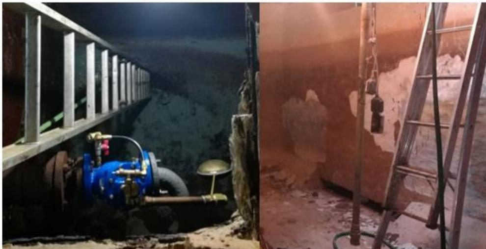
Figura 21 - Válvula de control de nivel – Boyas eléctricas
