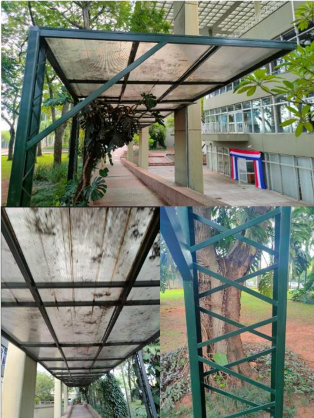
Figura 40 - Estructura metálica y techo de policarbonato, sector rampa a estacionamiento Tavapy
