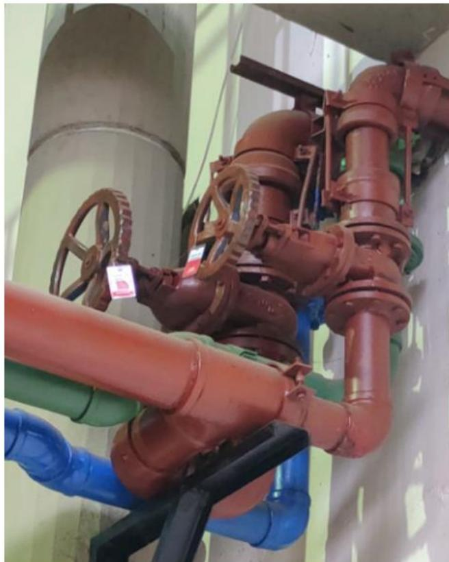
Figura 23 - Llaves de paso de cañería de incendio en el tanque inferior
