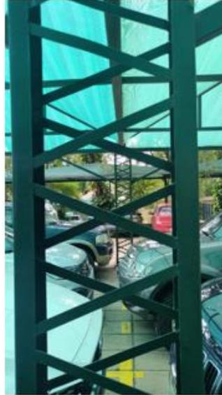
Figura 8 - Pilar reticulado de la estructura de media sombra
