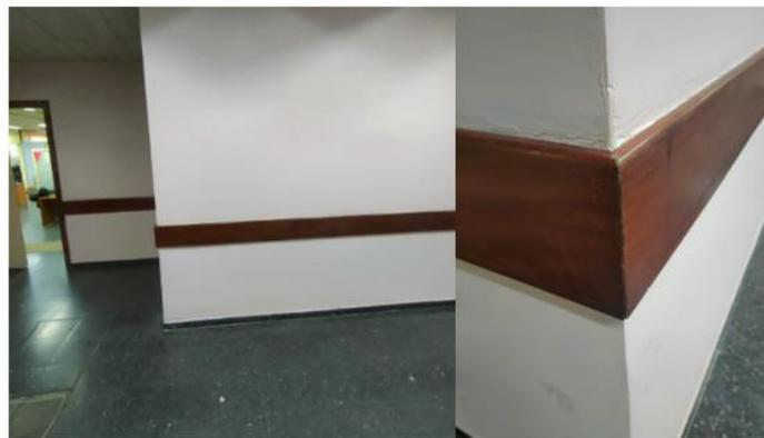
Figura 70 - Referencia de protectores ya colocados
