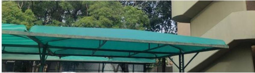
Figura 9 - Estructura de media sombra, vigas frontales y diagonales
