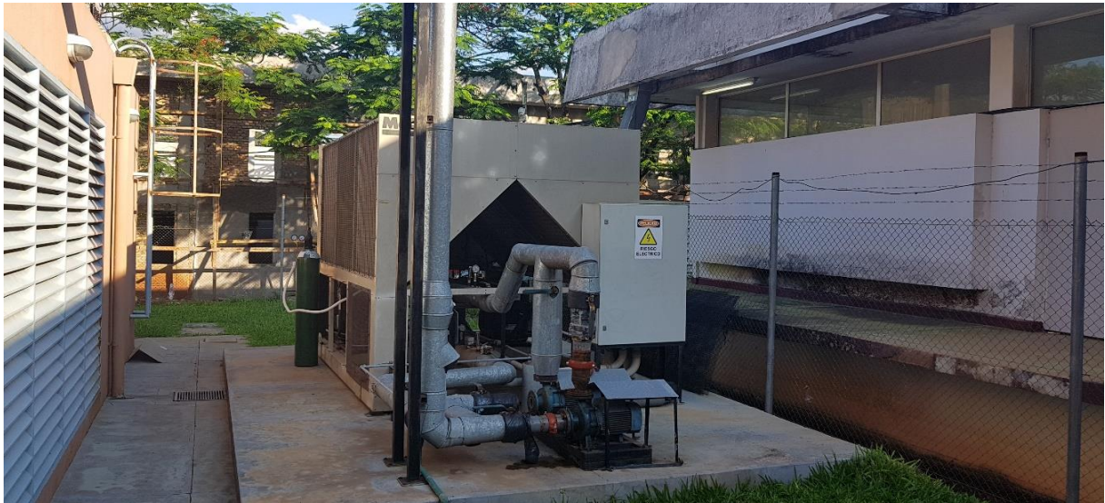
Chiller – Vista posterior y cuadro de bombas.
